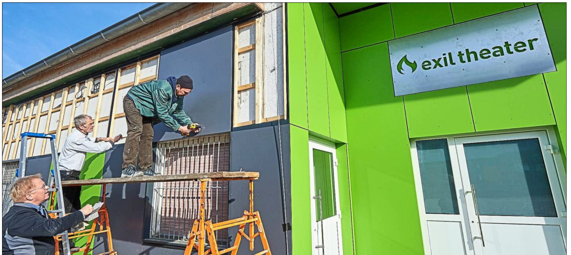
DIE BAUARBEITEN AM EXIL-THEATER sind auf der Zielgeraden. Die Arbeiten im ersten Bauabschnitt sollen bis Ostern fertig sein. Hartmut Ayrl, Bauleiter Martin Grobe und Vorsitzender Johannes Fuchs (von links) montierten an der ehemaligen Schraubenhandlung am alten Güterbahnhof zuletzt Fassadenplatten. Foto: Heintzen
